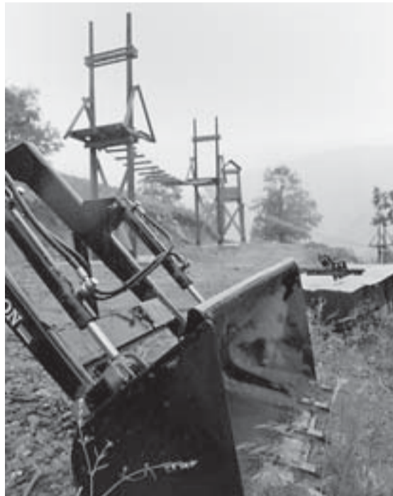
Las máquinas de la construcción están paradas en los terrenos donde se comenzó el parque. [J.C.]
